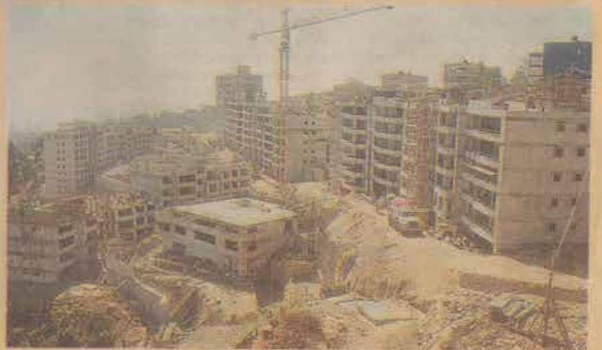
Condominio Mallén, obra financiada por el Banco del Desarrollo.
